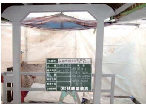
錆止め 下塗り 変性エポキシ樹脂プライマー (JASS18M-109) 品名:ニッペ ハイポンデクロ グレー
