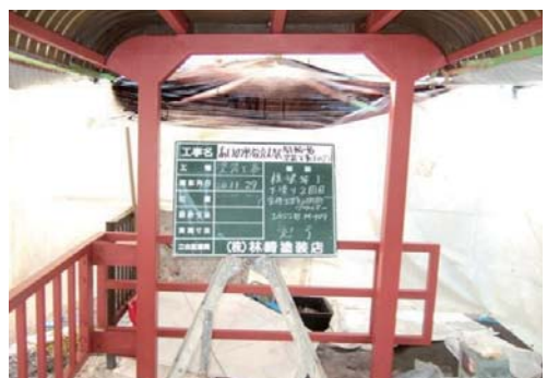
錆止め2回目 変性エポキシ樹脂プライマー (JASS18M-109) 品名:ニッペ ハイポンデクロ ブラウン
