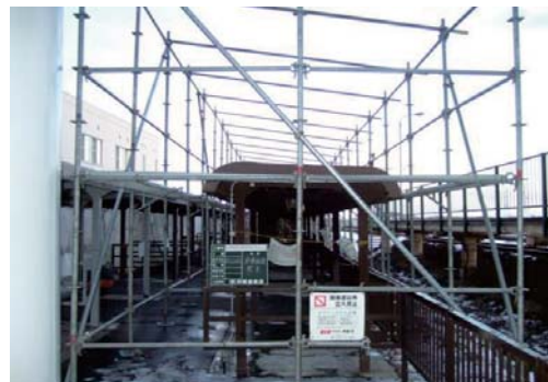
足場 夏期ならば、これほどの足場は必要ないのですが、冬季の為養生の問題もあり、大掛かりな足場になりました。
