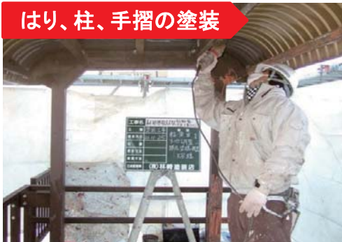
既存塗膜の除去 (専門用語でRB種下地調整と云います。)
