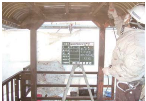
ディスクサンダー及び手工具により、劣化し脆弱な部分錆等を除去し、活膜は残します。
