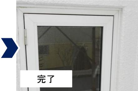
シーリングとは、外壁の継ぎ目部分やサッシ等、隙間から雨水等が入らないようにコーキング等の目地材を充填する事です。経年により劣化するため、外壁塗装工事に合わせて打ち替えをします。
